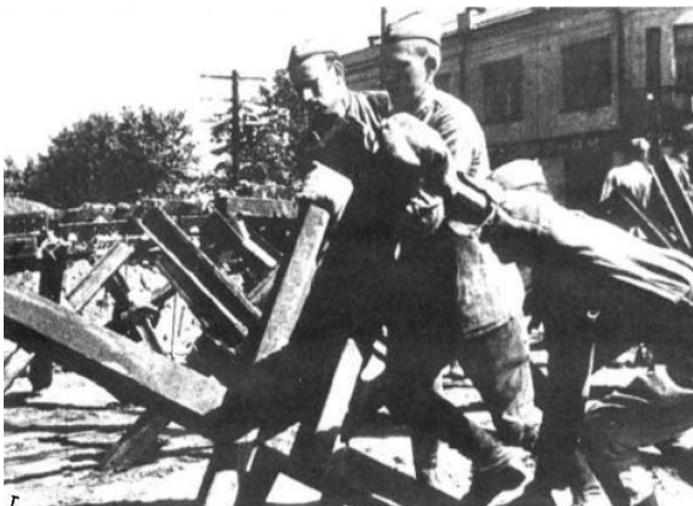
Строительство оборонительных сооружений. Киев, июль 1941 года.
